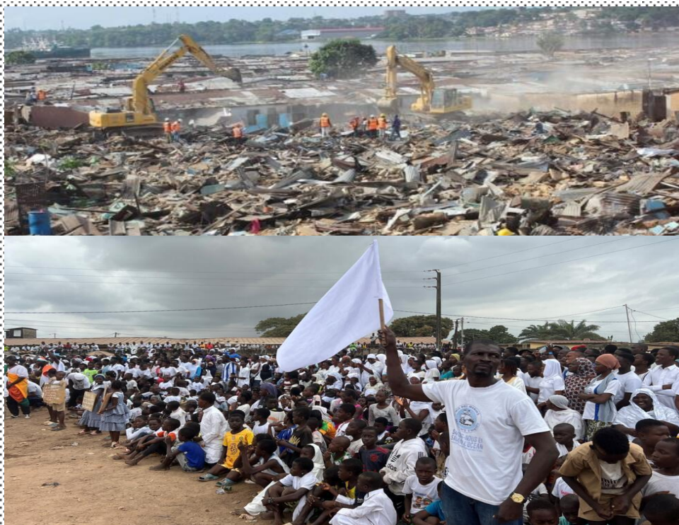
Démolition du quartier Boribana d'ans la commune d'Attecoutbé et rassemblement des habitants de Zimbabwe de la commune de Port Bouet pour demander que leurs habitations soient épargnées par les opérations de déguerpissement.
