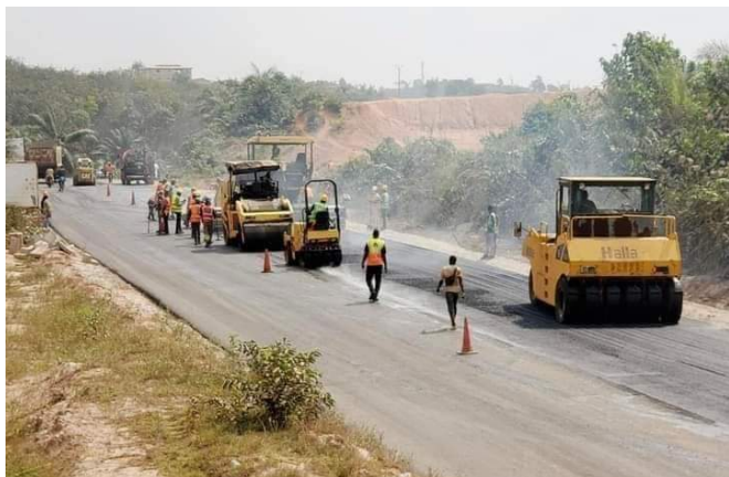
Travaux de construction sur l'axe Abidjan - Dabou - Sassandra - San Pedro - Tabou.
