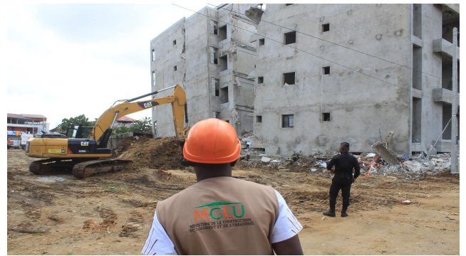
Le 21 juillet 2023, dans la commune de Cocody, des ouvriers sont en train de démolir un immeuble en construction car il menace de s'effondrer. Les promoteurs immobiliers se font beaucoup d'argent dans la construction de logements mais se moquent de la vie des ouvriers et des futurs locataires.
