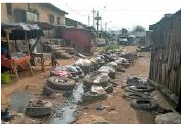
Égout à ciel ouvert à Abobo Derrière rail.
