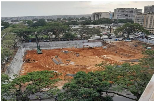
Début du chantier des tours à l'emplacement de l'ancienne Sorbonne du Plateau à Abidjan.
