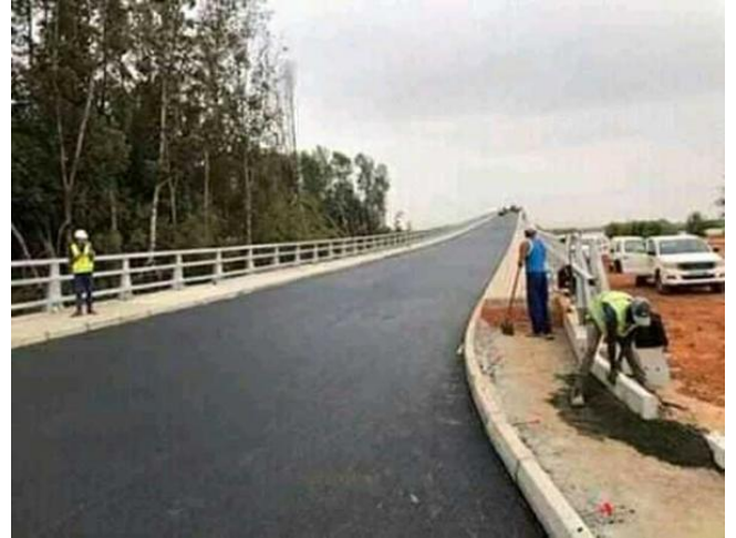
Le "transgambien" vers la fin des travaux
