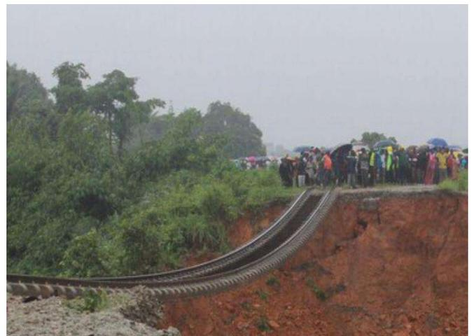
**Les rails du chemin de fer sont suspendus au-dessus du trou béant suite à un éboulement**
